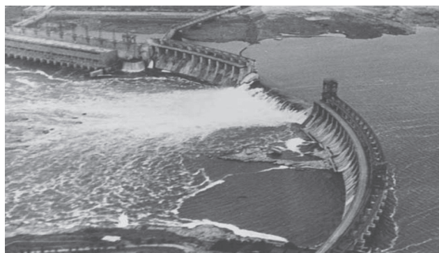
Разрушенная войной ДнепроГЭС
