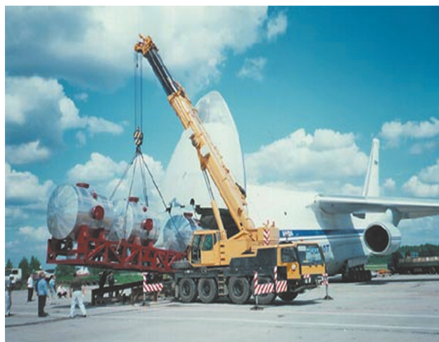
Рис. 3. Погрузка модуля установки подготовки пара Верхне-Мутновской ГеоЭС
